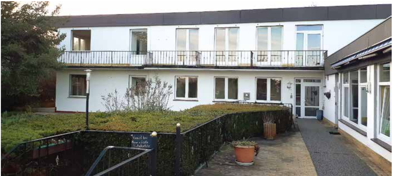
Außenansicht Am Unterscheid: Dort soll ein neues Angebot eingerichtet werden
