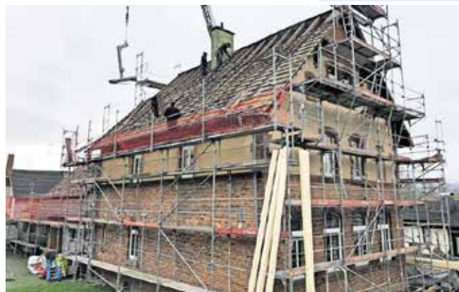
Jan Lange hat die Bauarbeiten dokumentiert – hier ein Foto von den Arbeiten. PRIVATFOTO
